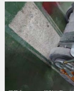
硬質床コーティング/切削工事 5mm程度
